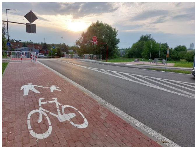
Rysunek 11. Przejazd kolejowy na ul. Nowy Świat
