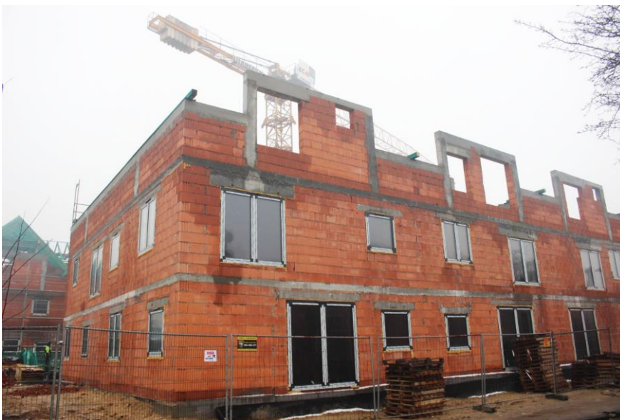
Rysunek 2. Budowa mieszkań komunalnych przy ul. Bankowej
