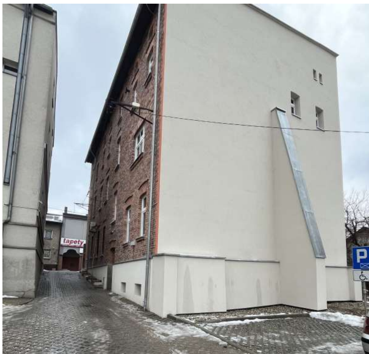
Modernizacja kamienicy przy ul. Dąbrowskiego 7 - Wirek - MPGM
