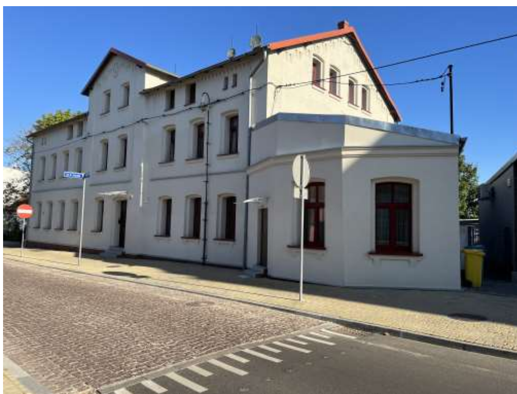
Termomodernizacja budynku przy ul. Janasa 13 - Ruda - MPGM
