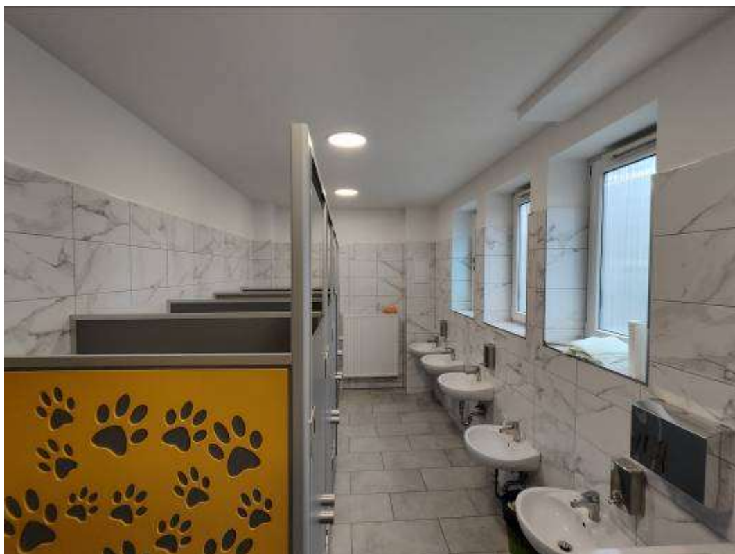
Modernizacja budynku SP-36- przy ul. Bytomskiej 45 - Wydział Inwestycji
