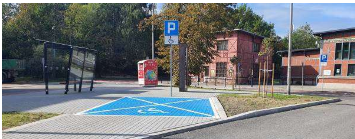
Przebudowa dróg gminnych ul. Dworcowej i ul. Przedtorze w Rudzie Śląskiej - Wydział Inwestycji
