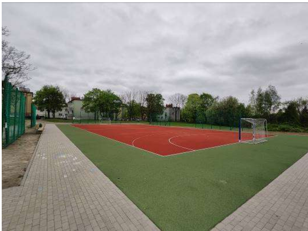
Modernizacja boiska przy SP-41 w Rudzie Śląskiej - Wydział Inwestycji
