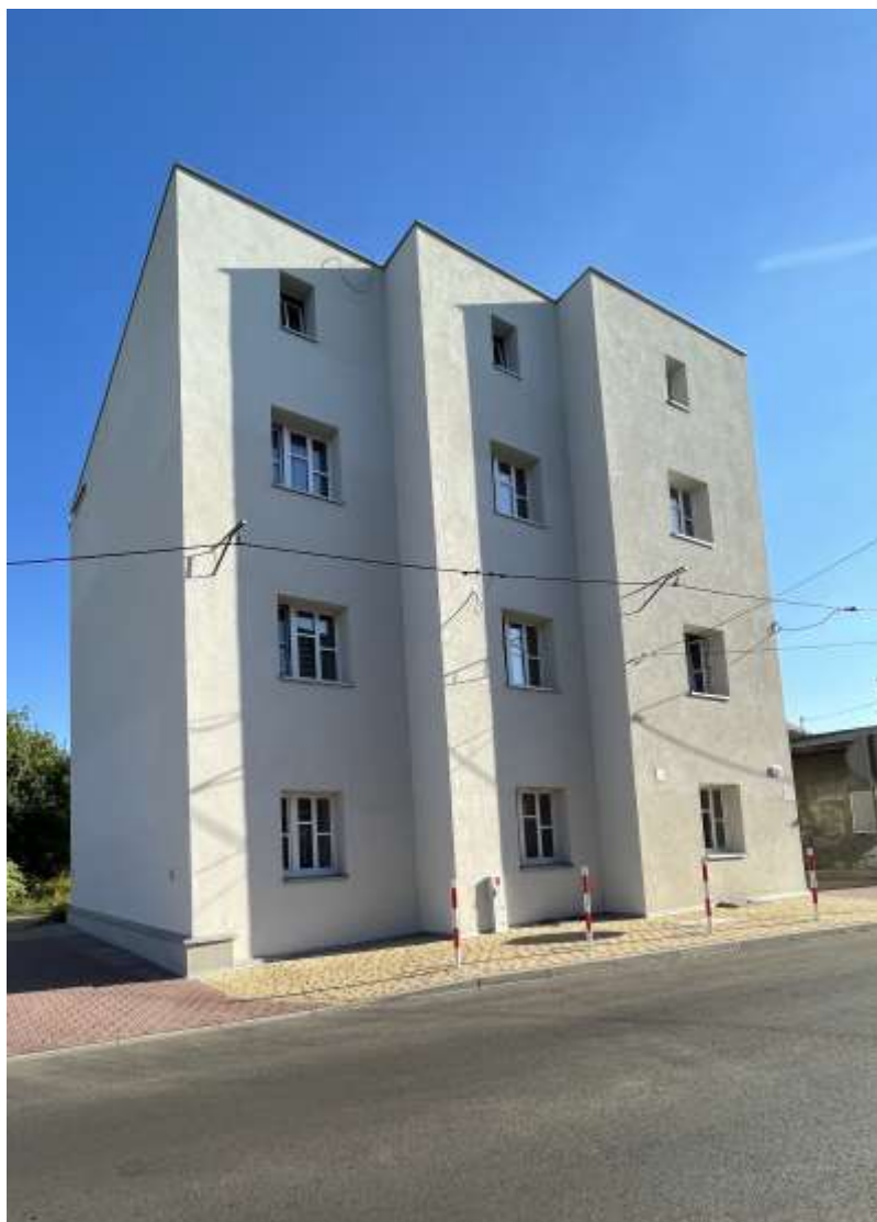
Termomodernizacja budynku przy ul. Janasa 17 - Ruda - MPGM
