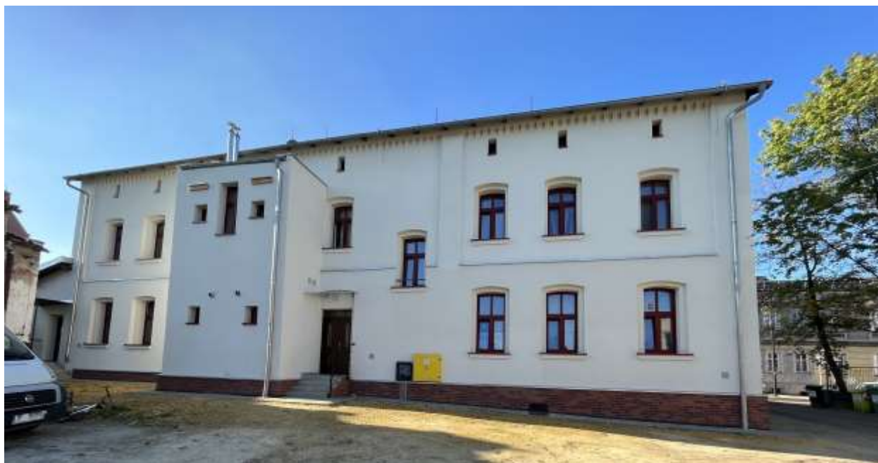
Termomodernizacja budynku przy ul. Janasa 13 - Ruda - MPGM
