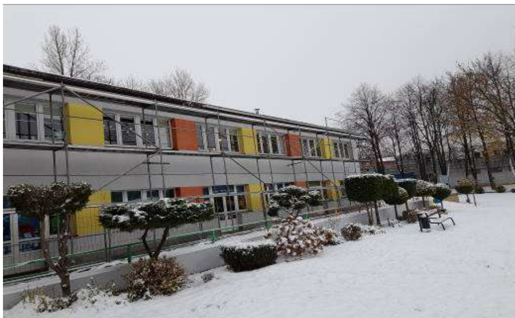
Budynek Zespołu Żłobków Miejskich przy ul. 1 Maja 286 w Rudzie Śląskiej - Wydział Inwestycji
