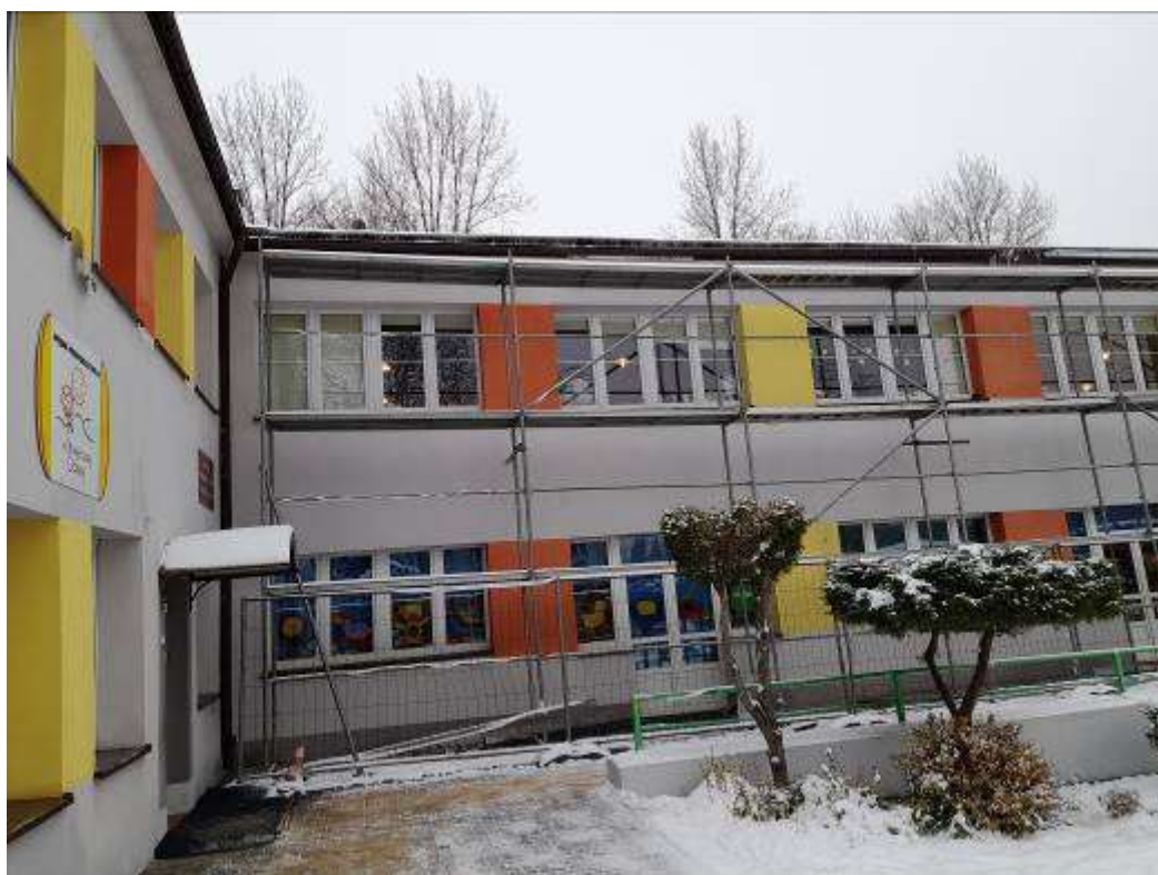
Budynek Zespołu Żłobków Miejskich przy ul. 1 Maja 286 w Rudzie Śląskiej - Wydział Inwestycji
