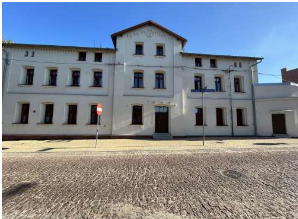
Termomodernizacja budynku przy ul. Janasa 13 - Ruda - MPGM
