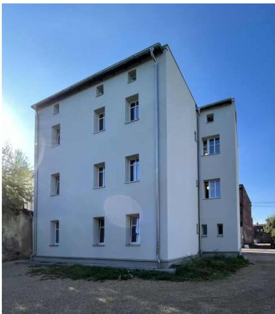
Termomodernizacja budynku przy ul. Janasa 17 - Ruda - MPGM
