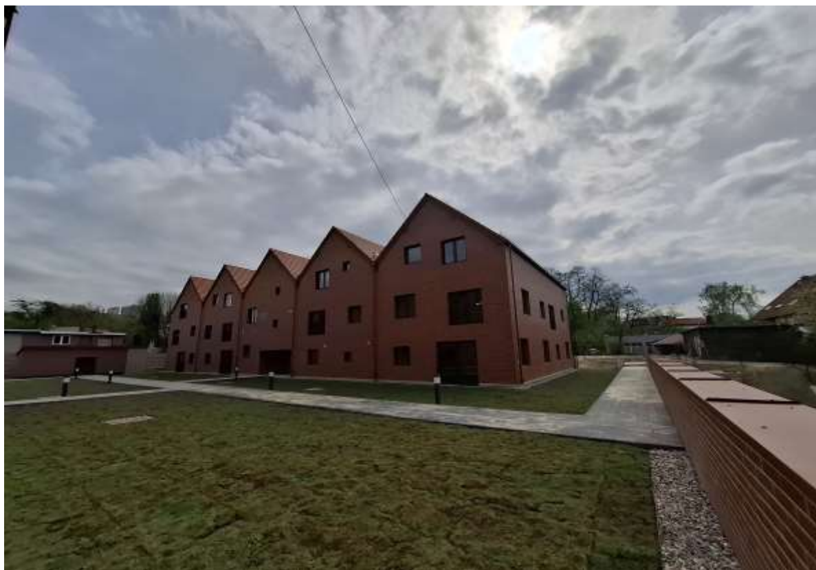
Mieszkania komunalne przy ul. Bankowej - Wydział Inwestycji
