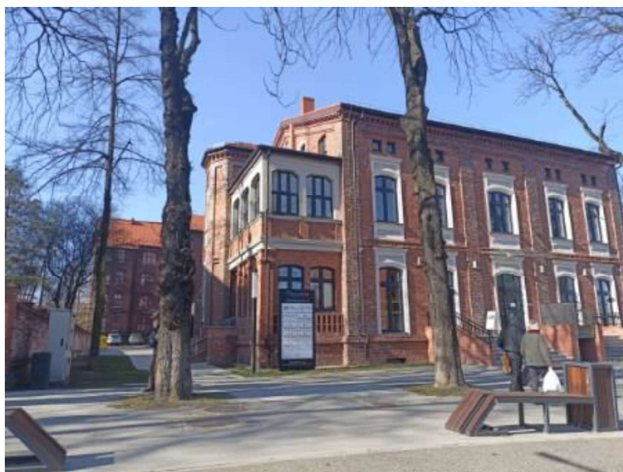
Zmodernizowany budynek usługowy przy ul. Niedurnego 75
