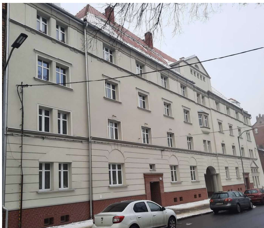
Zabytkowy budynek mieszkalny przy ul. Bytomskiej 39-41 poddany termomodernizacji
