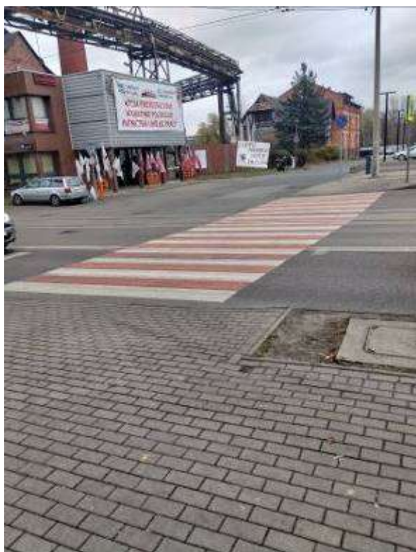
Rysunek 34. Przejście dla pieszych na ul. Niedurnego przy Hucie Pokój, przykład przejścia bez elementów ostrzegawczych w chodniku
