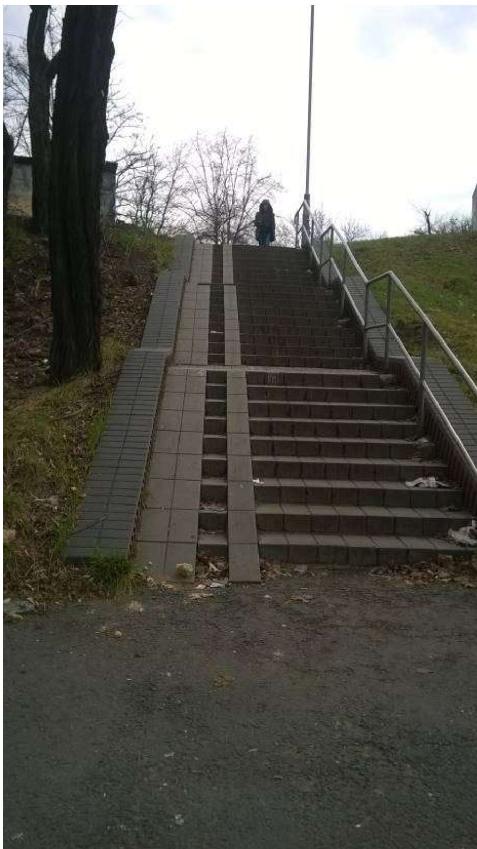
Rysunek 65 Przykład długich schodów z podjazdem dla wózków dziecięcych z poręczą po jednej stronie
