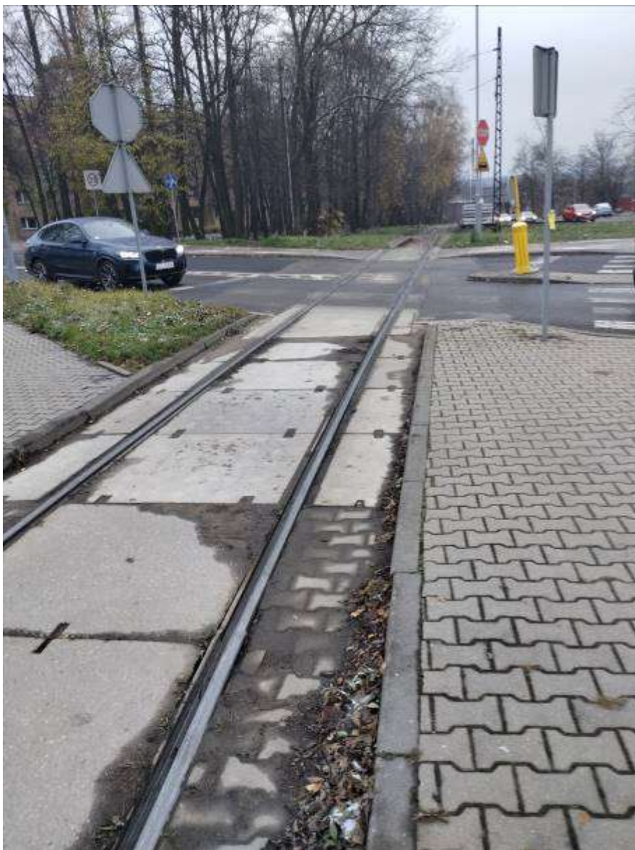
Rysunek 21. Przejście przez ul. Obrońców Westerplatte przy torach tramwajowych
