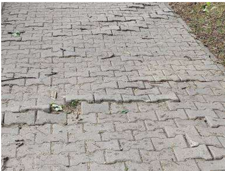
Rysunek 48. Chodnik przy ulicy Katowickiej
