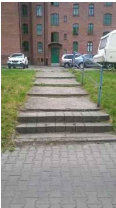
Rysunek 23. Schody na podwórku w okolicach przystanku przy ul. Czarnoleśnej
