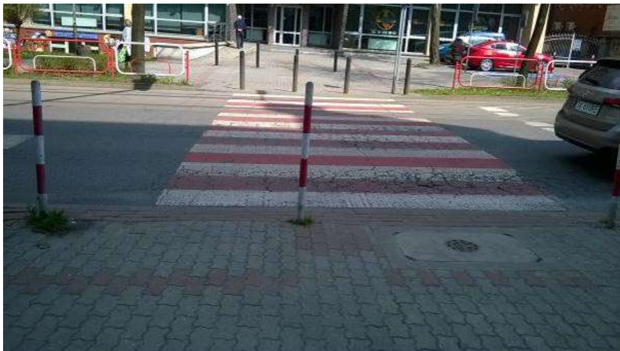
Rysunek 33. Przejście dla pieszych na ul. Niedurnego przy Szkole Muzycznej
