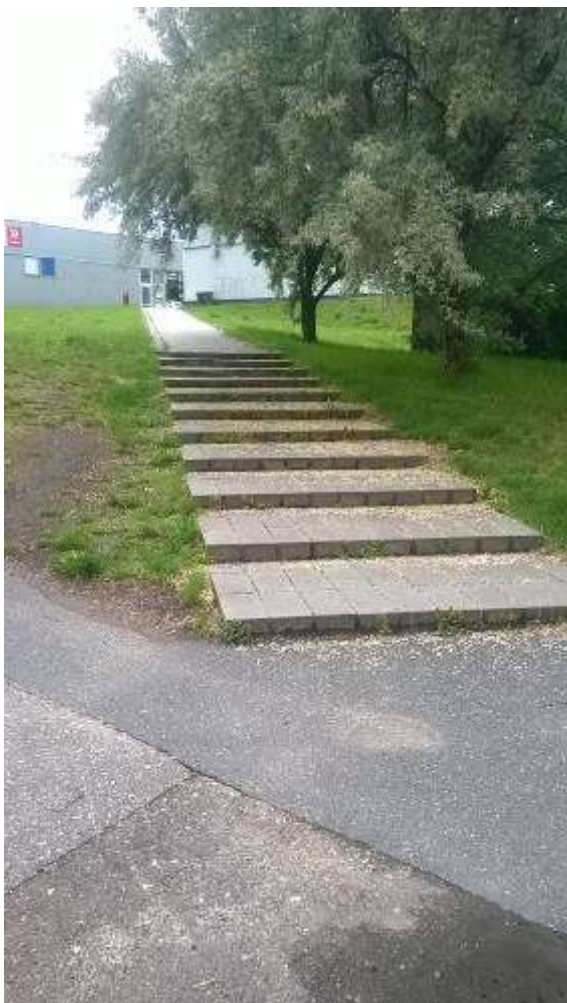
Rysunek 66. Przykład schodów bez poręczy i podjazdu z długimi stopniami
