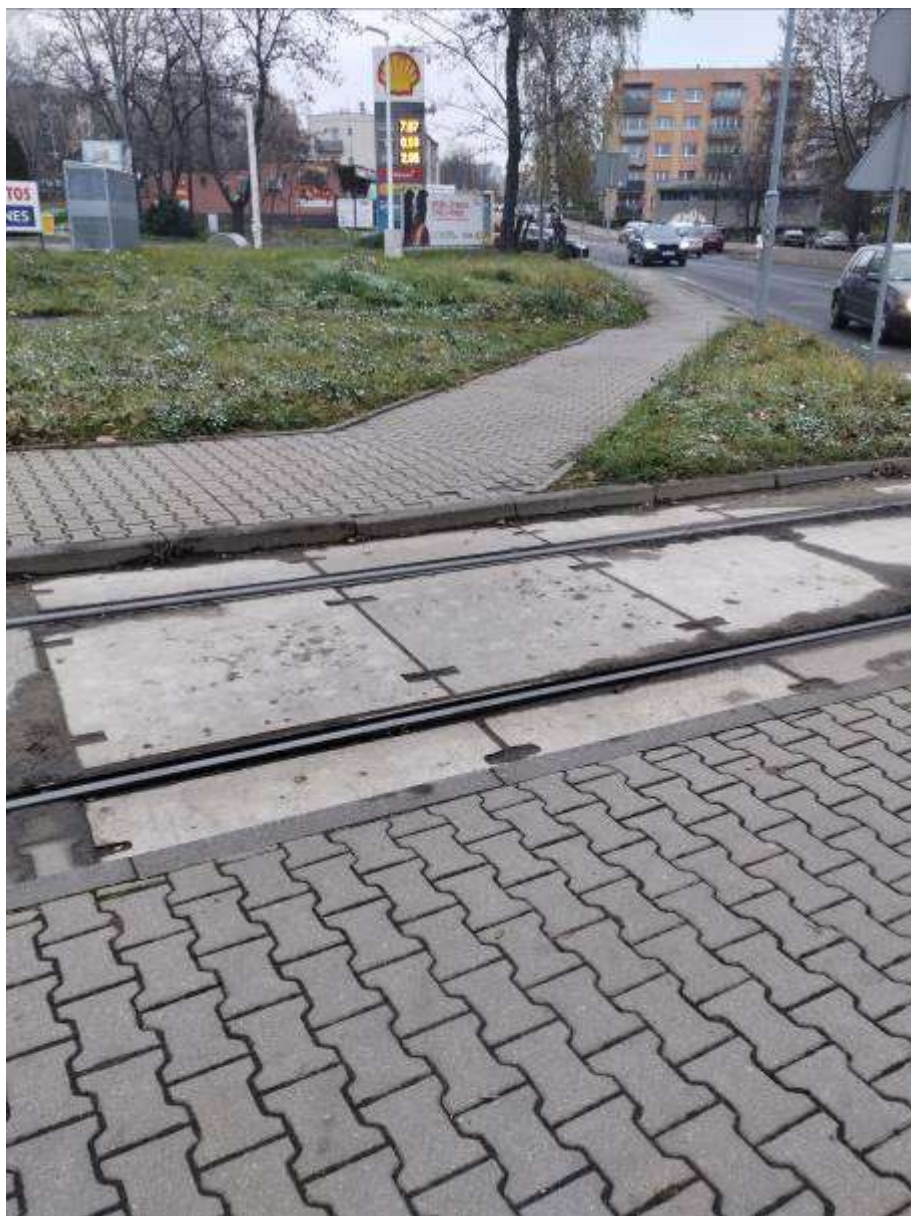
Rysunek 20. Przejście przez tory tramwajowe, przystanek Wirek KWK Pokój
