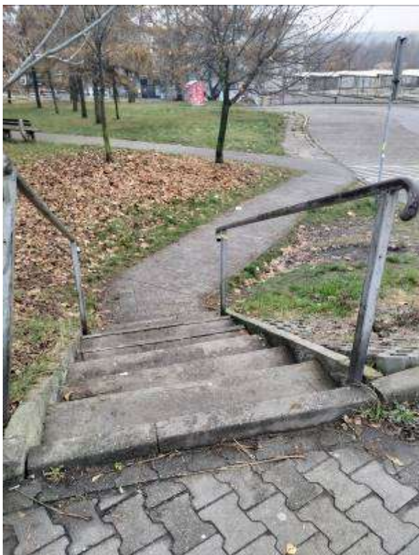
Rysunek 71. Przykład schodów bez podjazdu z wystającym krawężnikiem
