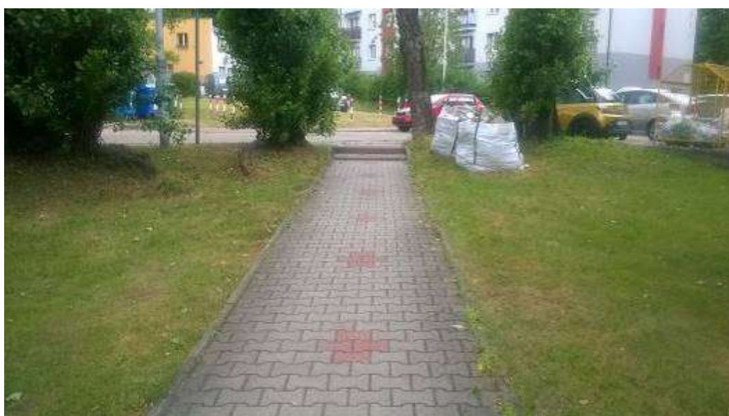
Rysunek 62. Przykład schodów przy końcu chodnika, bez podjazdu, które trudno ominąć
