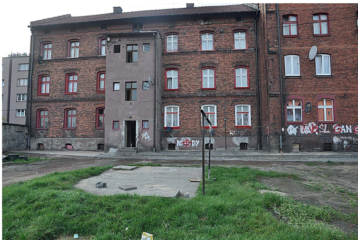
Problemy związane z brakiem podłączenia do kanalizacji ogólnospławnej – szambo na podwórku
