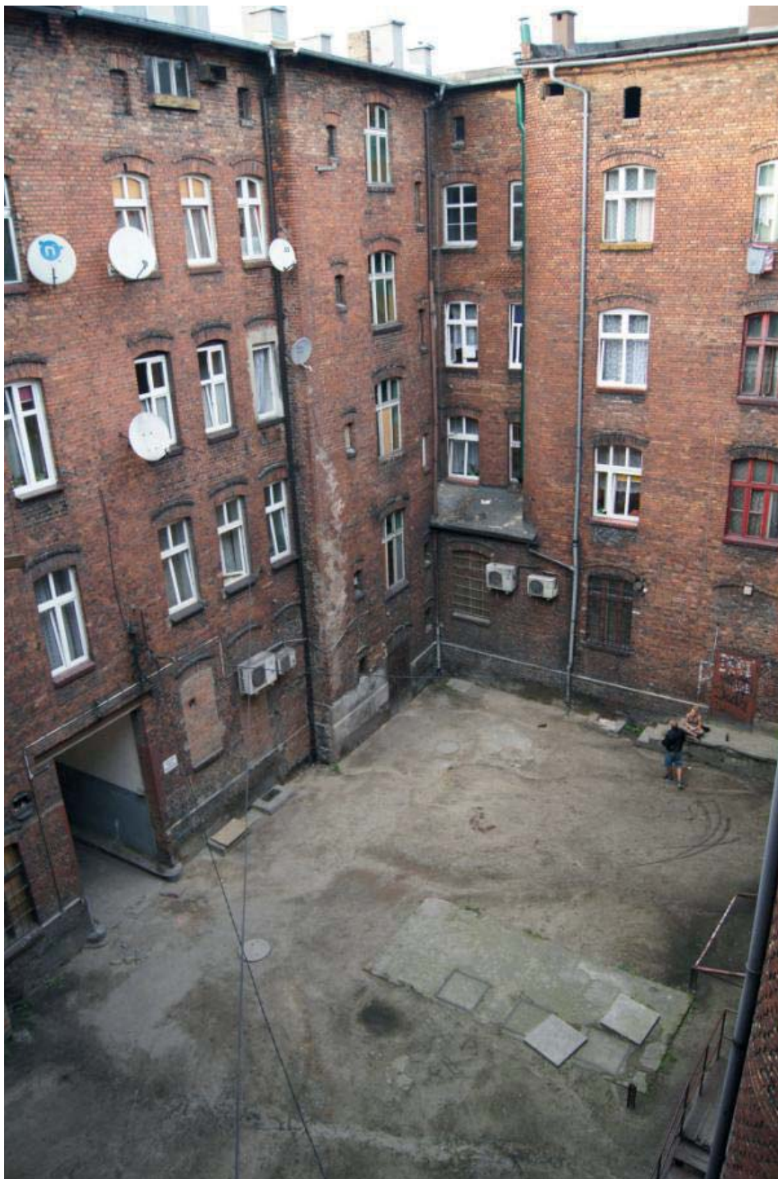
Zdj. 5: Widok z okna klatki schodowej
