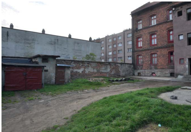
Zdj. 2: Garaż i budynki gospodarcze.
