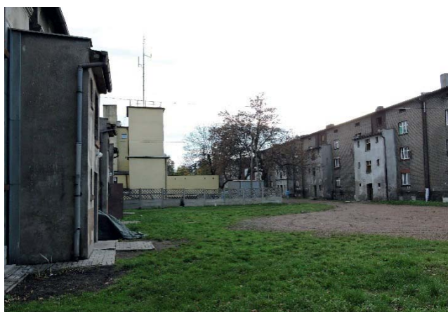
Zdj. 5: Widok od strony północno-wschodniej placu.
