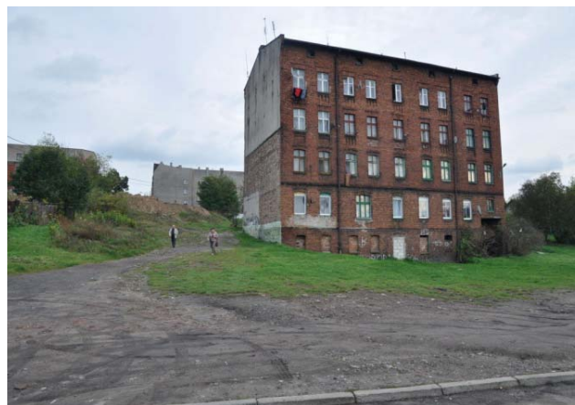
Zdj. 2: Wolna, nieurządzona przestrzeń
