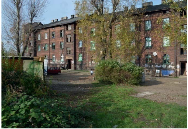
Zdj. 2: Widok na podwórko od strony muru.
