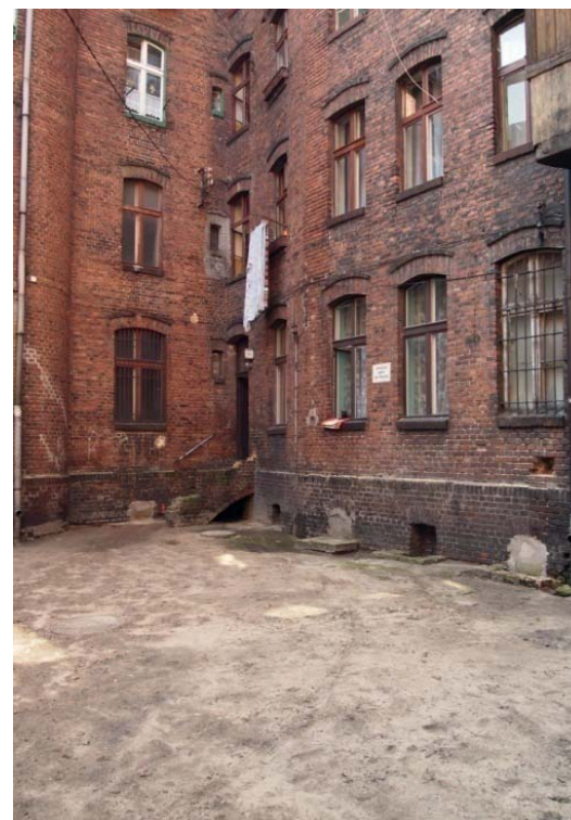
Zdj. 4: Widok na elewację południowo-zachodnią
