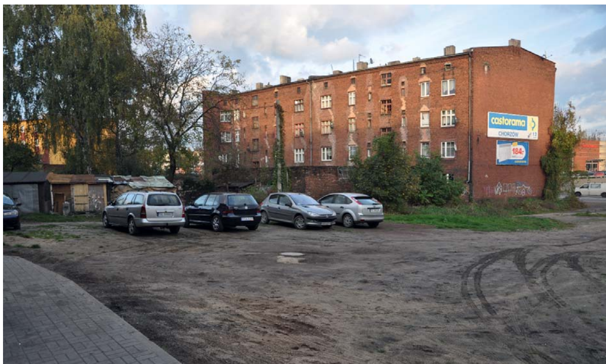
Problemy związane z brakiem utwardzonych miejsc do parkowania
