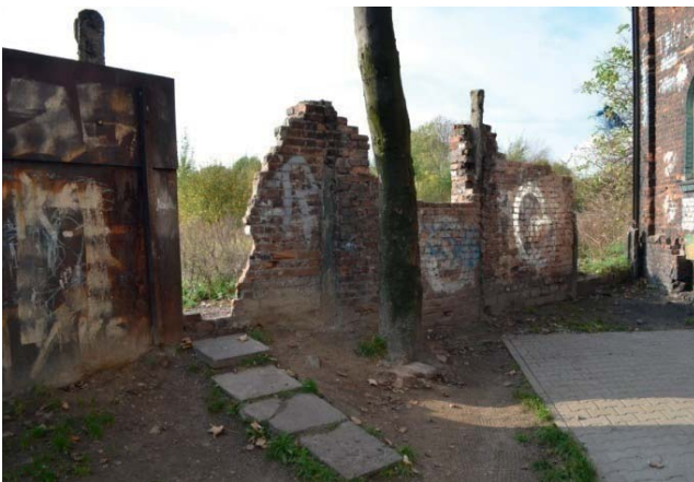
Zdj. 5: Pozostałości muru oddzielającego podwórko od torów kolejowych.
