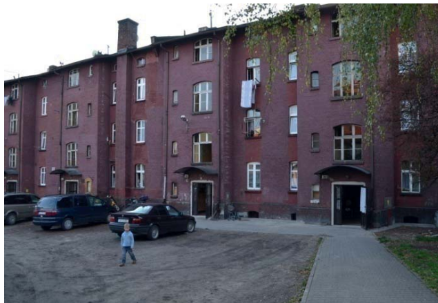
Zdj. 2: Dojście do budynku mieszkalnego.
