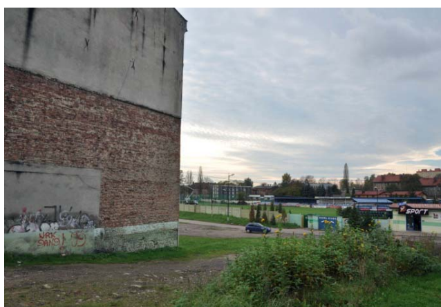
Zdj. 3: Przejście koło budynku
