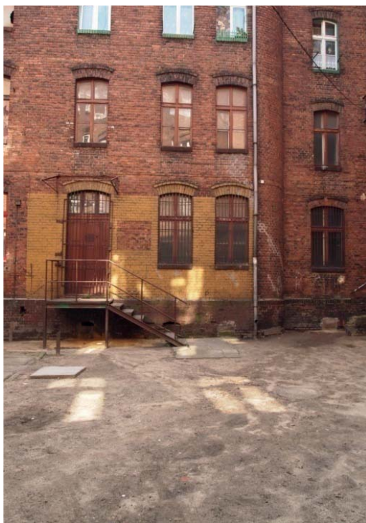
Zdj. 3: Widok na elewację południową
