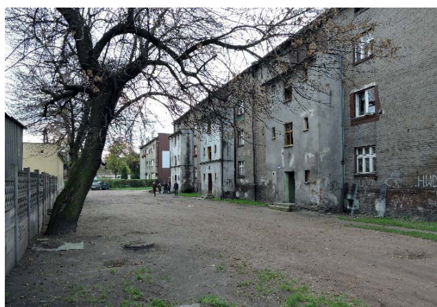
Zdj. 4: Wejścia do klatek ul. W. Kałusa 18, 20, 22.
