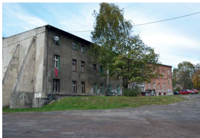
Zdj. 4: Widok na południowe elewacje kamienic zlokalizowanych przy ul. Sienkiewicza.
