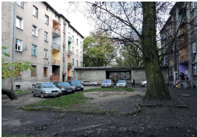
Zdj. 2: Widok na przełączkę – tworzącą bramę na podwórko.
