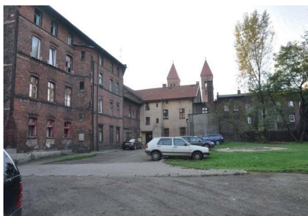
Zdj. 4: Nietwardzona nawierzchnia.
