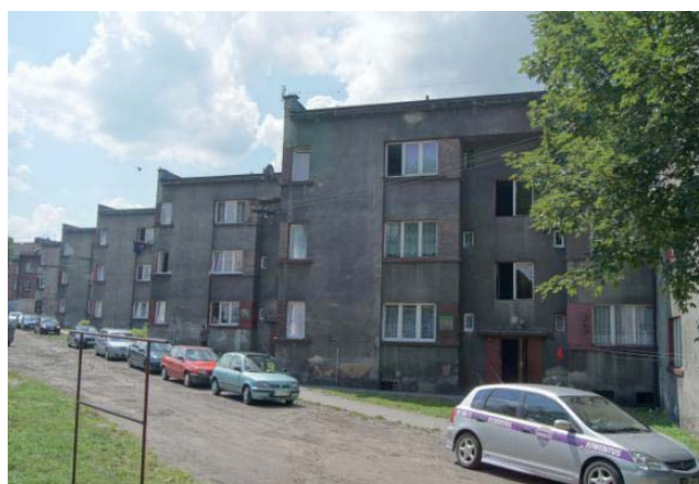
Zdj. 6: Brak nawierzchni utwardzonej w pasie jezdnym
