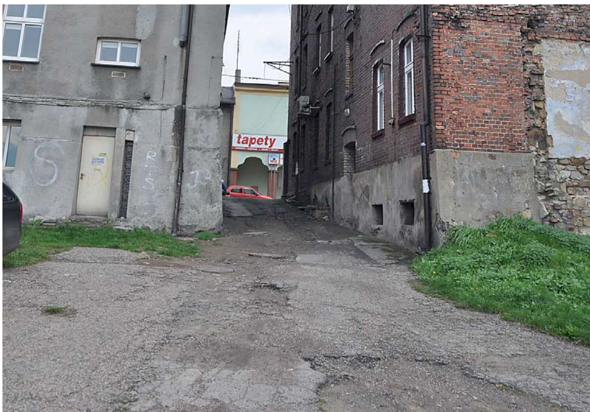
Problemy związanych ze złym stanem nawierzchni dróg oraz odwodnieniem
