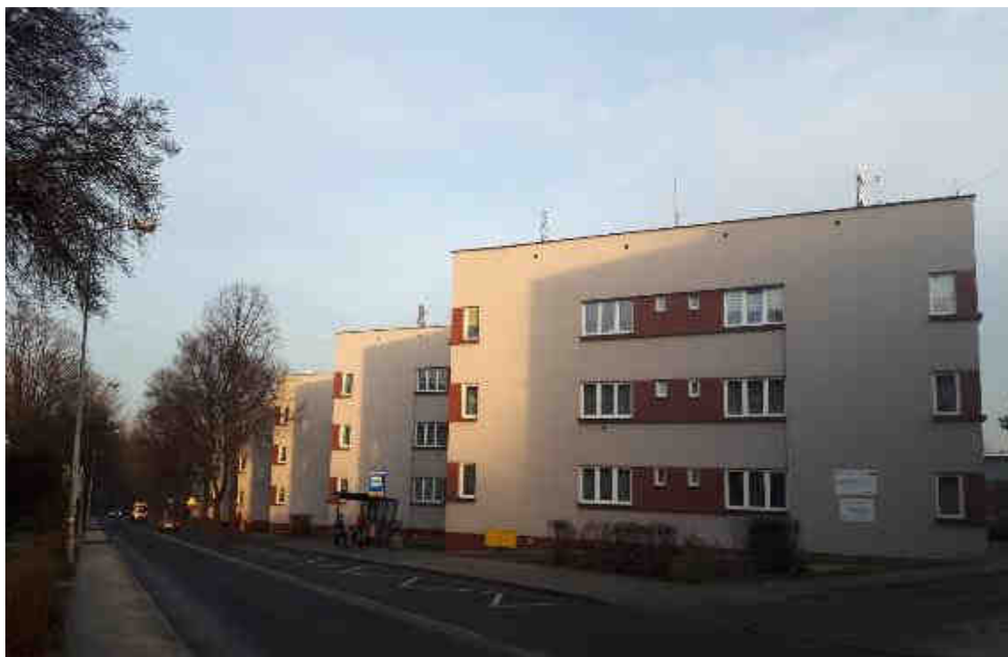
P.1.4/U.13.8. Termomodernizacja budynku przy ul. Matejki 2-12 - Ruda
