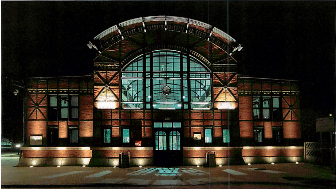
Stacja Biblioteka - Chebzie
