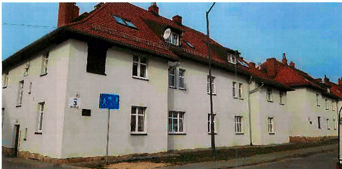
Modernizacja zabytkowego kwartału kolonii robotniczej Carl Emmanuel
