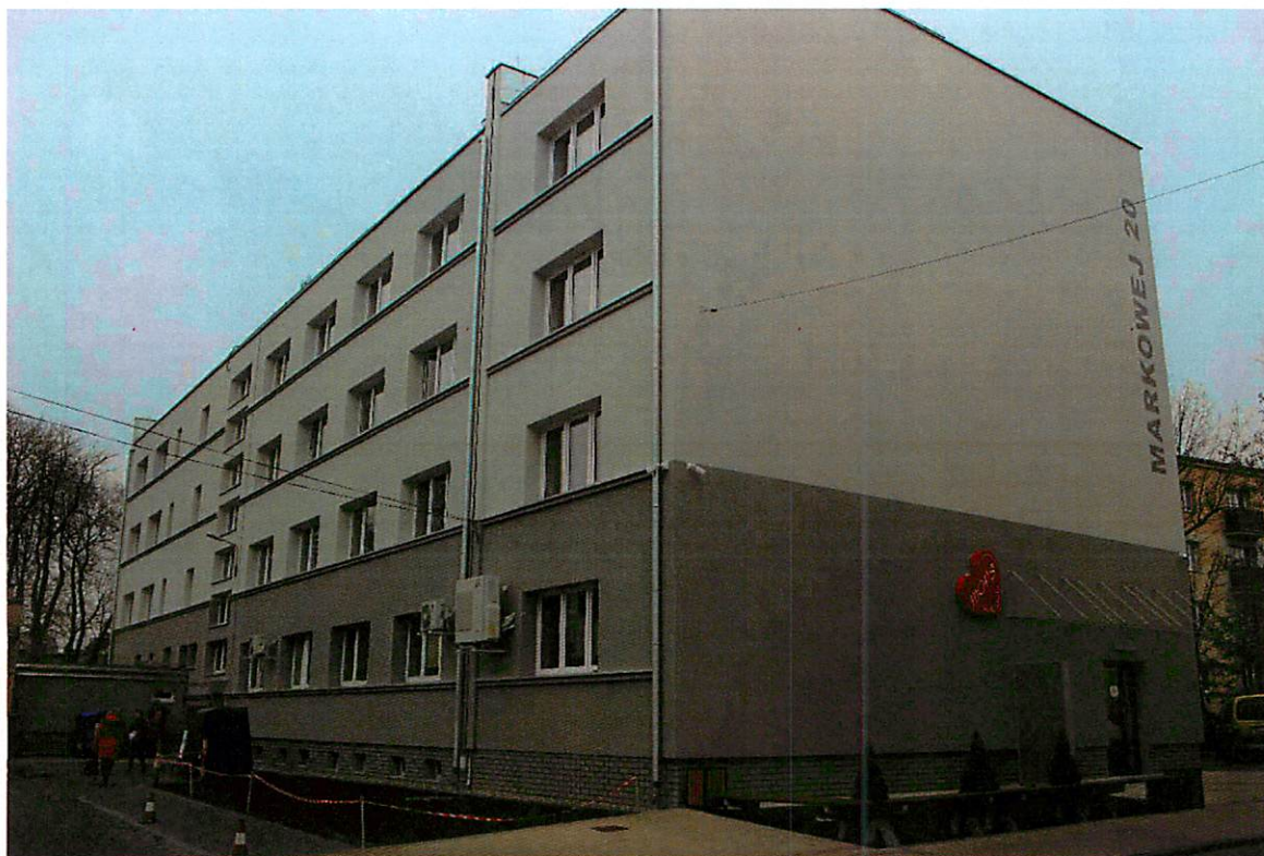
Modernizacja budynku Miejskiego Ośrodka Pomocy Społecznej
