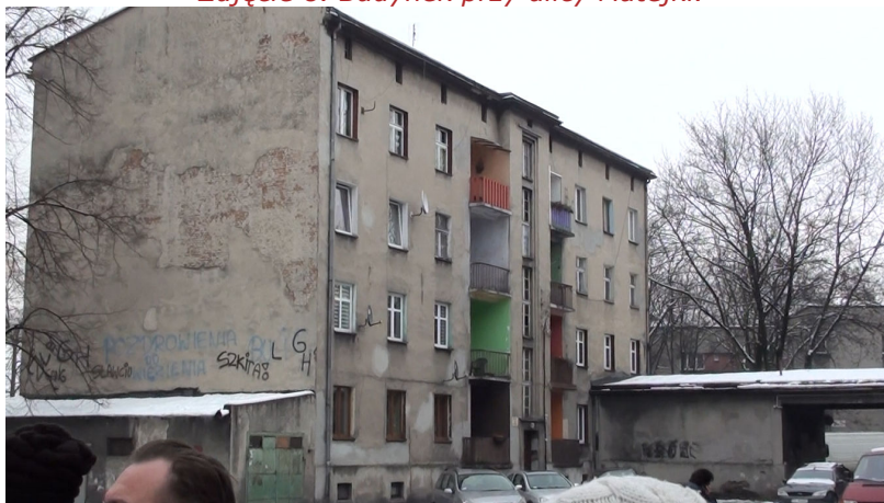
Zdjęcie 8. Budynek przy ulicy Matejki.
