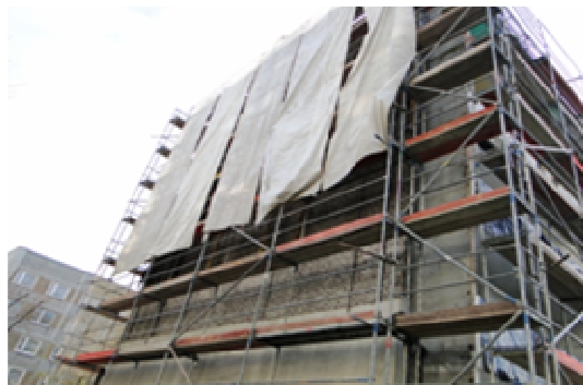
w trakcie renowacji
