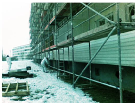
w trakcie renowacji
