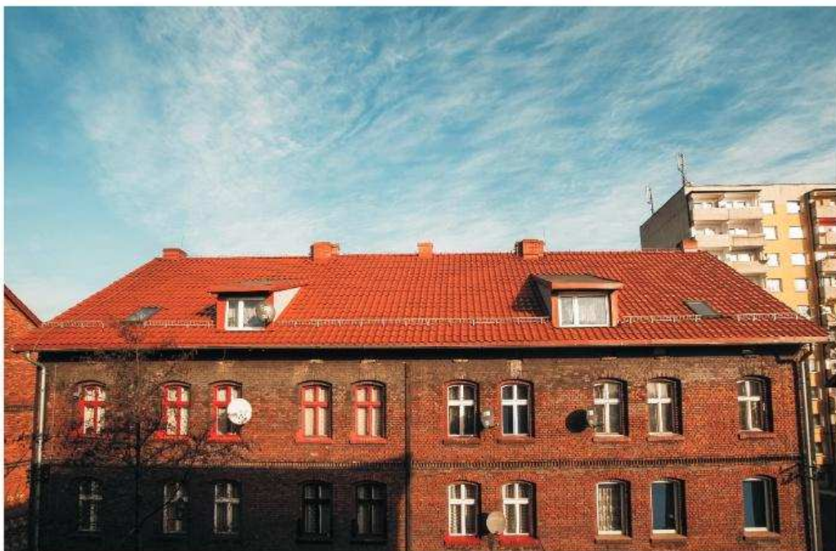
wyremontowany dach budynku przy ul. Bytomskiego 24
