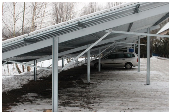
Instalacja fotowoltaiczna - basen na Nowym Bytomiu
